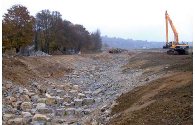
Fischaufstieg Zugwiesen in Bau
